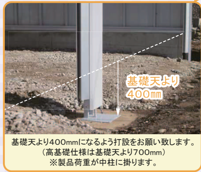
アジャスターで多少の高さ調整が出来ます。調整範囲は374~414mmです。
